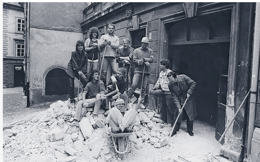
Baubeginn der Galerie im Jahr 1989
