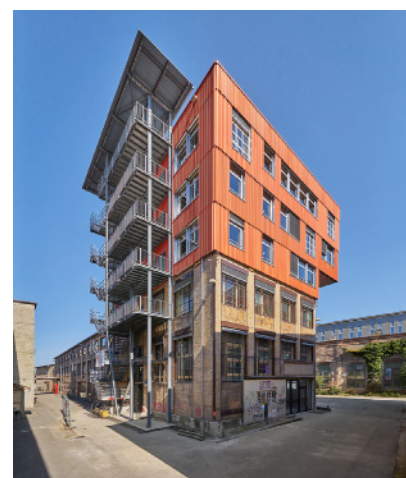
K118 Baubüro in situ fotografia Martin Zeller
